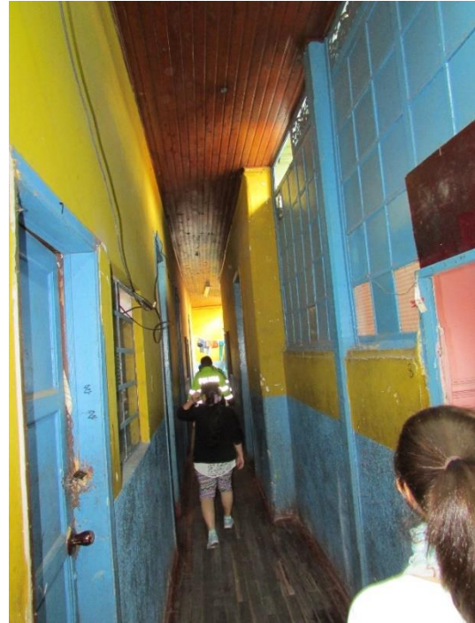
Imagen 60 Estado Actual estructura espacial y funcional
