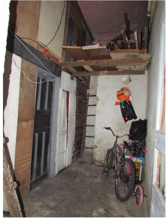
Imagen 74 Estado Actual estructura espacial y funcional
