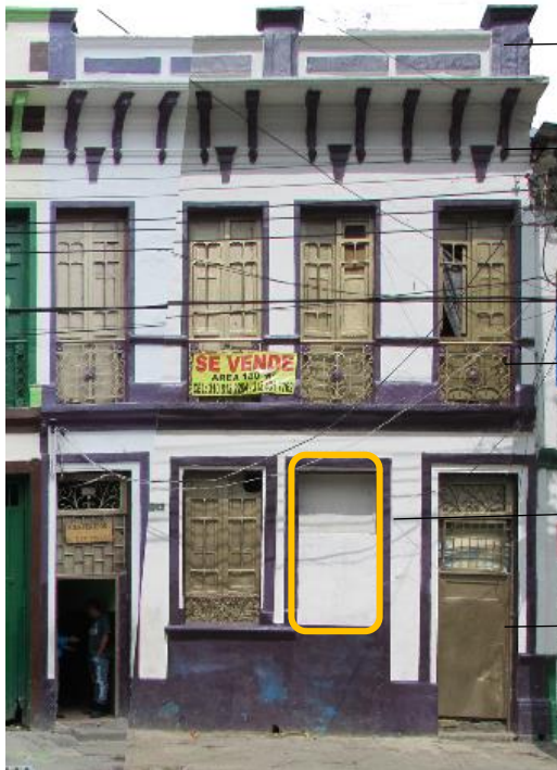
Imagen 24 Elementos de fachada
