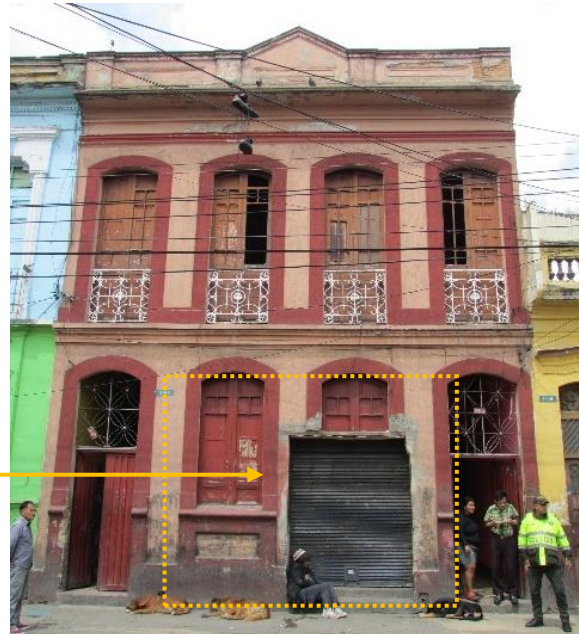
Imagen 56 Estado Actual fachada
