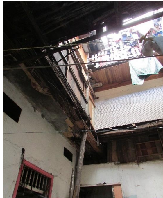
Imagen 72 Estado Actual patito
