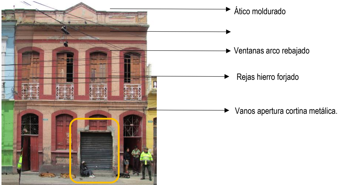
Imagen 54 Elementos de fachada
