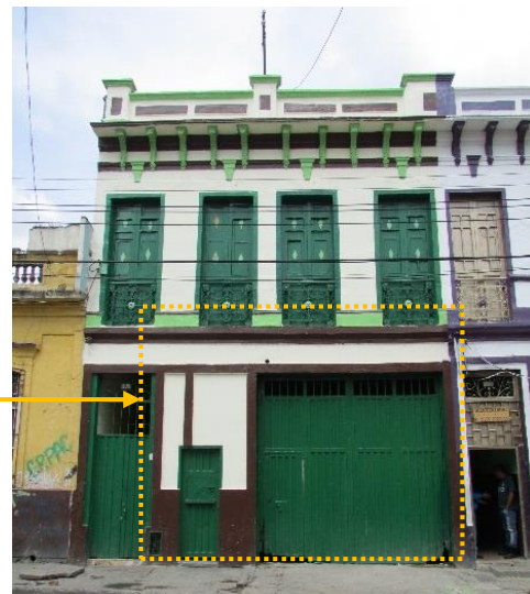
Imagen 39 Estado Actual fachada
