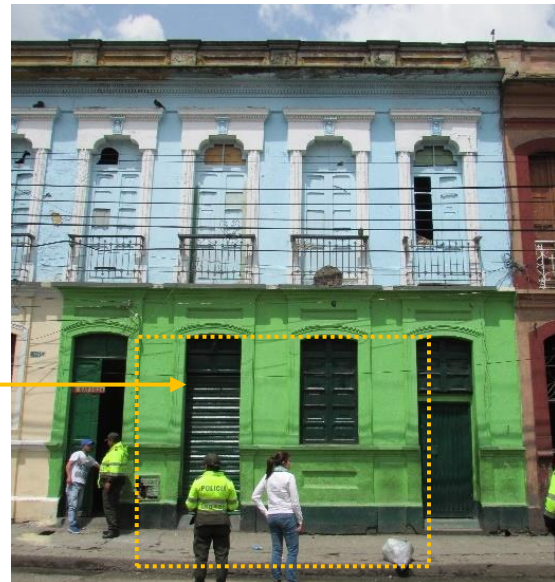
Imagen 70 Estado Actual fachada
