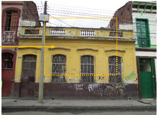
Imagen 46 Estado Actual fachada
