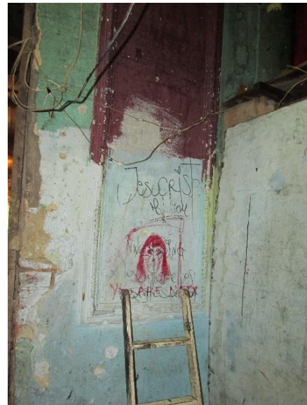
Imagen 28 Estado Actual segundo piso
