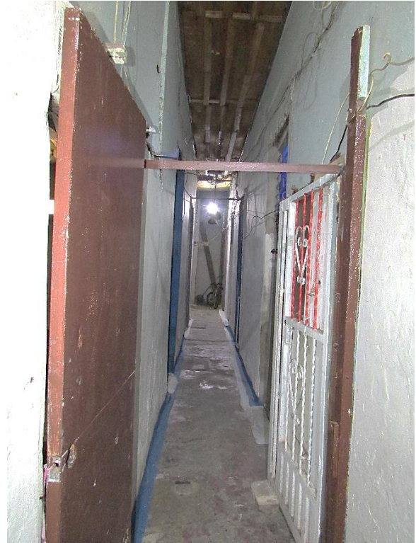
Imagen 30 Estado Actual estructura espacial y funcional
