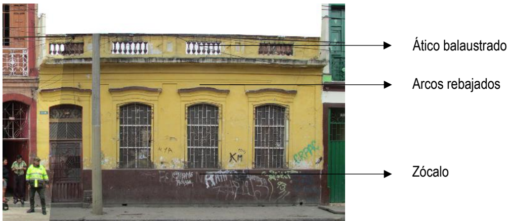
Imagen 44 Elementos de fachada
