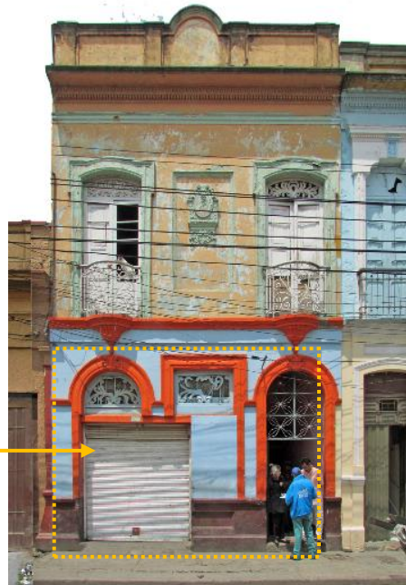
Imagen 83 Estado Actual fachada
