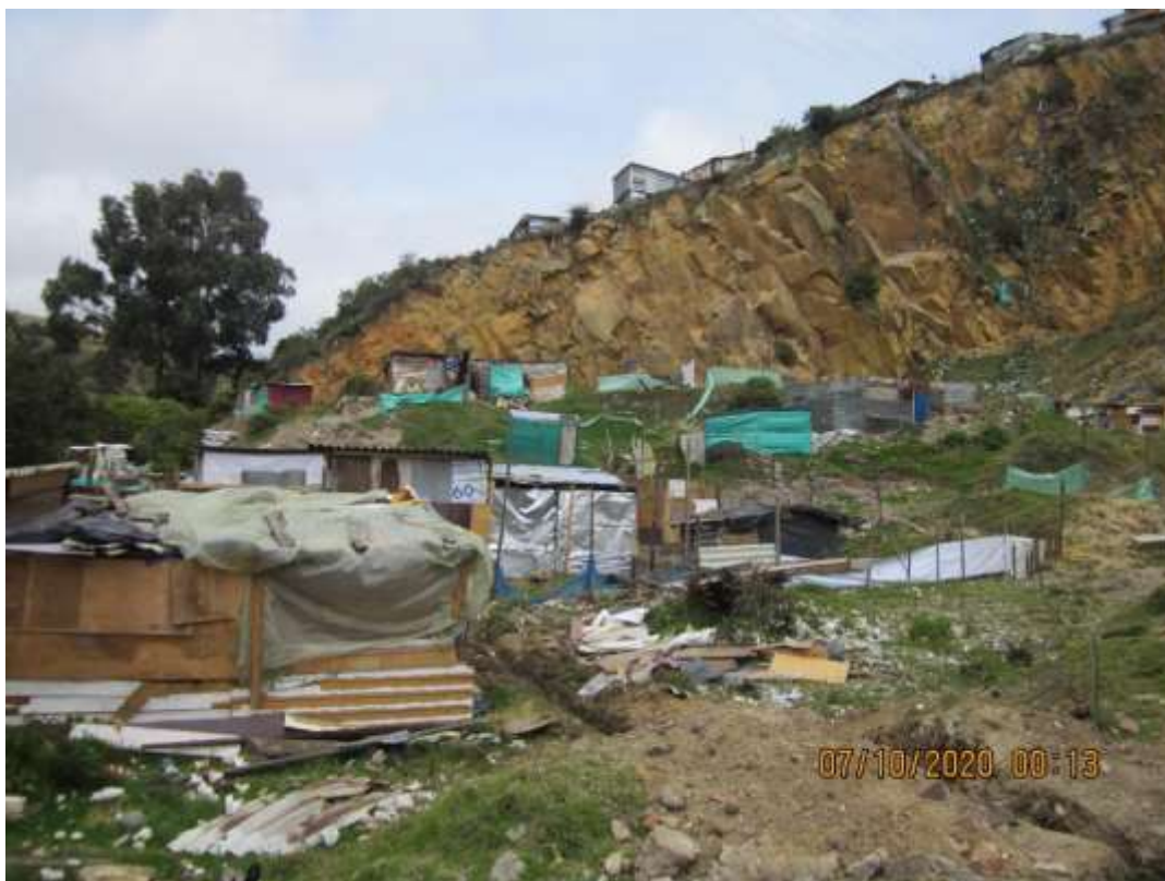
Se aprecia en el patio de la cantera inactiva sin instrumento ambiental la construcción de las viviendas en materiales reciclados, como madera y láminas de zinc, y cerca de la corona del talud viviendas presuntamente en riesgo
