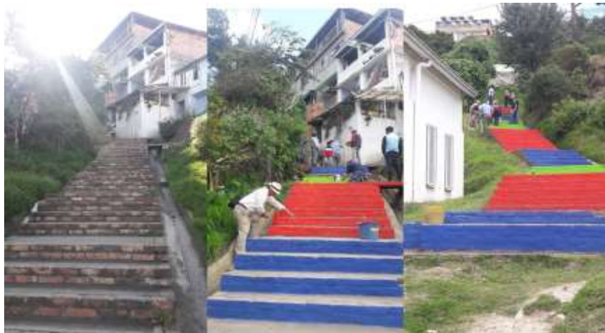
Figura 7. Pintura de escaleras de acceso en la franja de adecuación con participación comunitaria.
