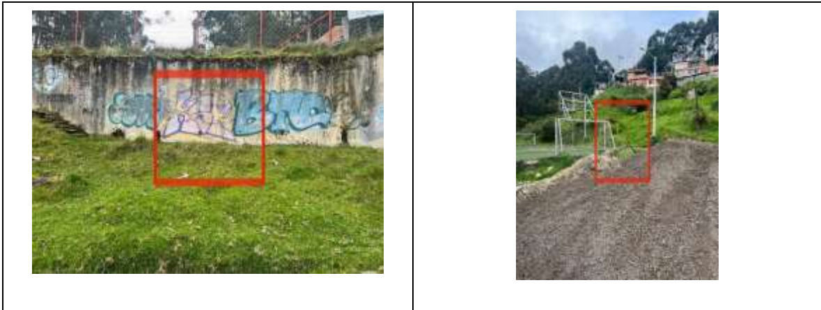
Figura 18. Puntos de instalación vallas.
