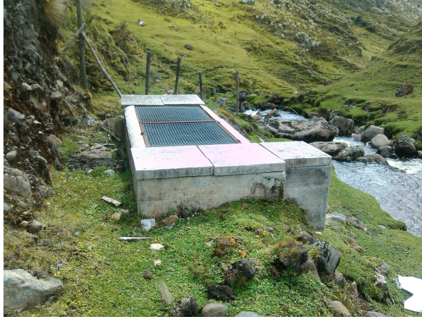
IMAGEN 2 – Desarenador existente.
