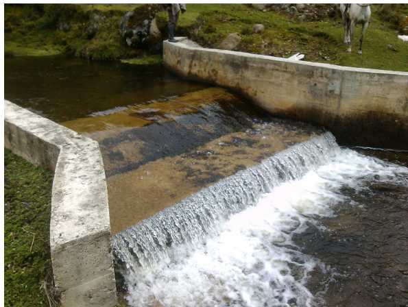
IMAGEN 1 – Bocatoma existente.
