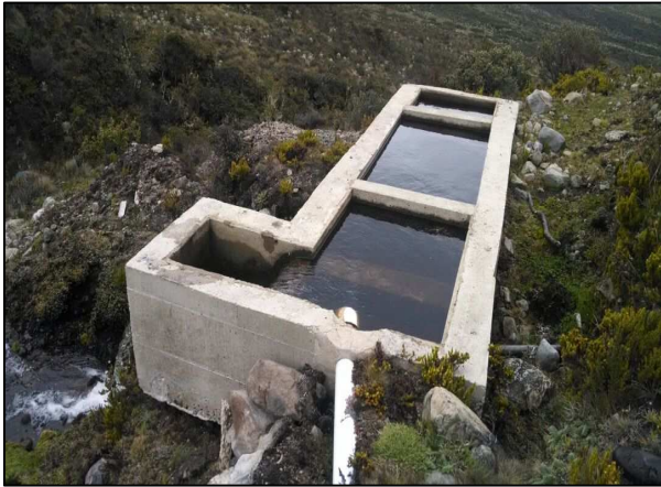
IMAGEN 2 – Desarenador existente.
