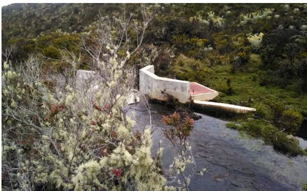
IMAGEN 1 – Bocatoma existente.
