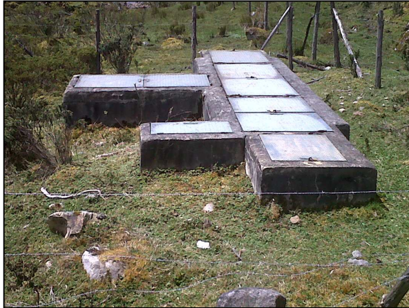
IMAGEN 2 – Desarenador existente.
