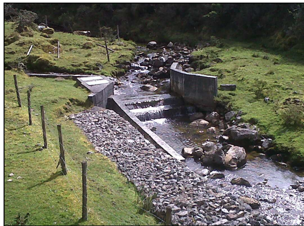
IMAGEN 1 – Bocatoma existente.
