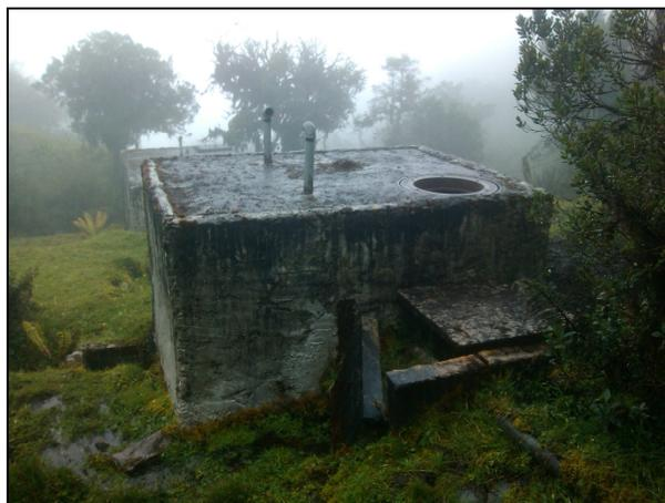
IMAGEN 2 – Desarenador existente.
