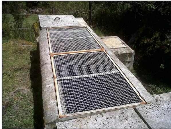
IMAGEN 5 – Desarenador existente.
