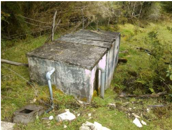
IMAGEN 5 – Desarenador existente.
