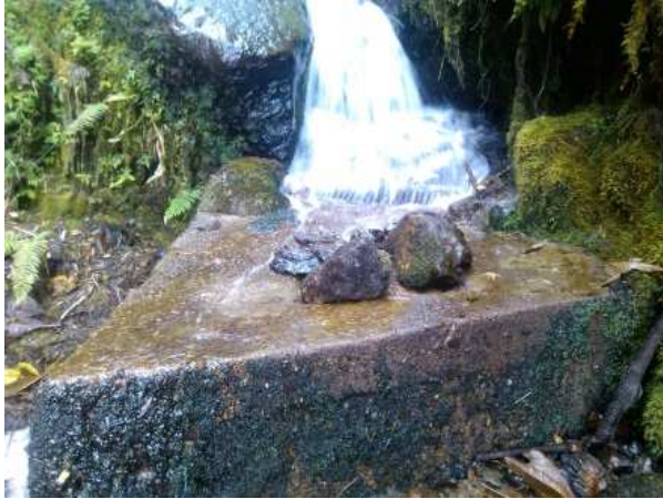
IMAGEN 1 – Bocatoma existente.
