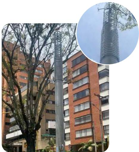
Corresponde a un elemento de forma cilíndrica, instalado en la parte superior de la infraestructura de soporte, cuya función corresponde a mimetizar los elementos radiantes (antenas) de la estación radioeléctrica. Es un elemento liviano, fabricado en materiales ligeros como el policarbonato, el cual permite el adecuado paso del espectro radioeléctrico a través de este. La altura máxima de este elemento en el espacio público no supera los 3,00 m y un diámetro de 0,70 m.
