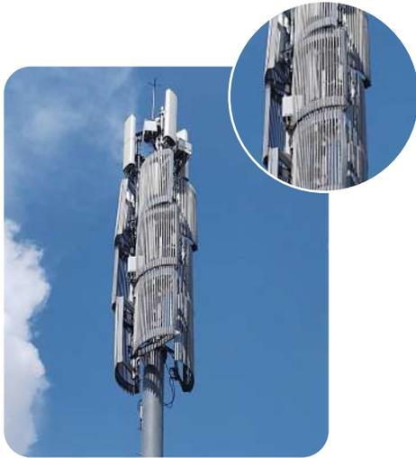
Corresponde a un elemento en forma de rejilla, instalado en la parte superior de la infraestructura de soporte, cuya función corresponde a mimetizar los elementos radiantes (antenas) de la estación radioeléctrica.
