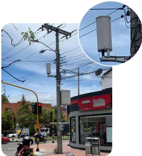
Corresponde a una solución basada en estaciones radioeléctricas de pequeño formato (microceldas, picoceldas, femtoceldas) apropiadas en lugares con una alta afluencia de personas como el espacio público en general.
