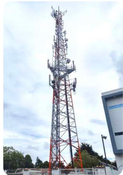
Figura 1.7. Estructura de soporte. Torre autosoportada
