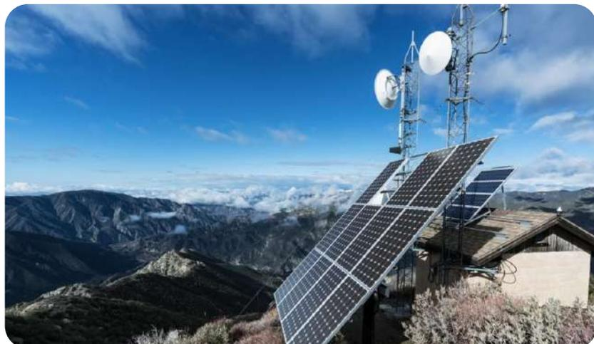
Figura 1.47. Uso de paneles solares en estaciones radioeléctricas de telecomunicaciones
