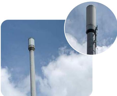
Son sistemas de mimetización visualmente similares a una chimenea; las antenas son recubiertas con paneles anclados a una estructura metálica en forma de cilindro. Se recomienda la implementación de esta solución en entornos ubicados sobre los tratamientos de conservación y consolidación; al tratarse de elementos aplicables sobre edificaciones.
