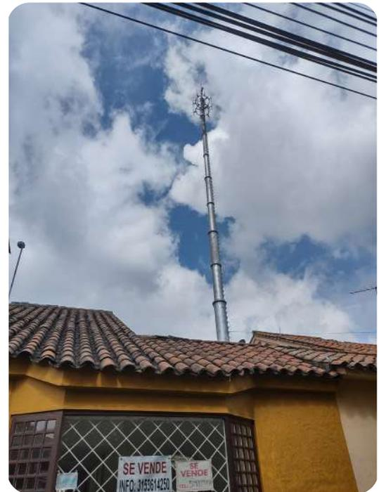
Figura 1.16. Estaciones radioeléctricas tipo monopolo, instaladas en el espacio público
