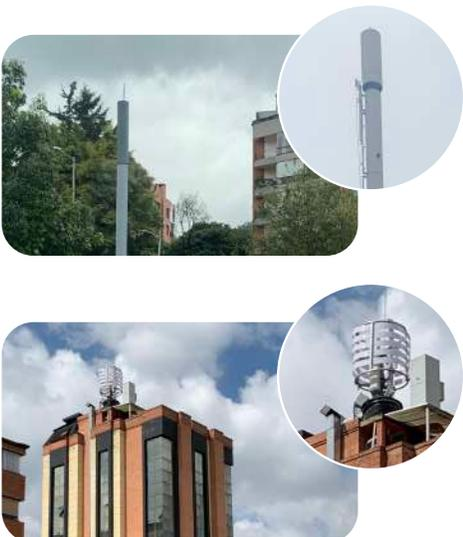
Corresponde a un elemento de forma cilíndrica, instalado en la parte superior de la infraestructura de soporte, cuya función corresponde a mimetizar los elementos radiantes (antenas) de la estación radioeléctrica.
