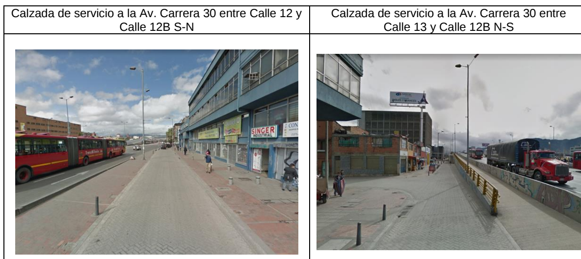
Figura 3-2. Estado actual de la calzada de servicio a la Av. Carrera 30 desde la Av. Calle 13 hasta la Calle 12
