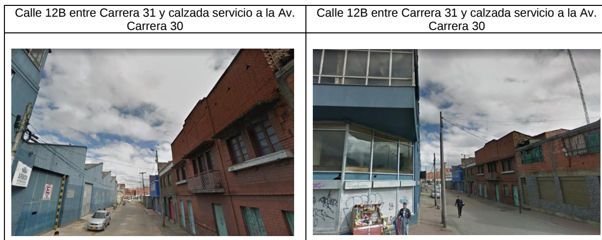
Figura 3-3. Estado actual de la Calle 12B entre la Carrera 30 y Carrera 31
