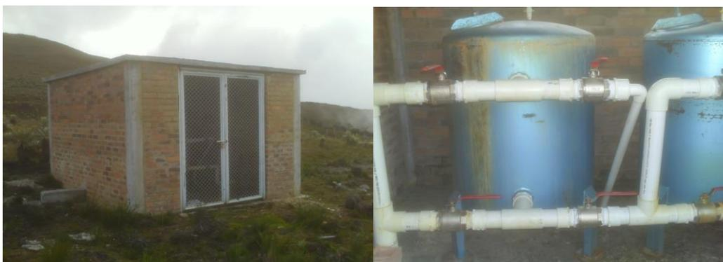
Figura 61. Planta de Tratamiento y Cerramiento Vereda San Antonio y El Toldo – Abierta las válvulas del paso directo. Fuente: Acodal, 2009
