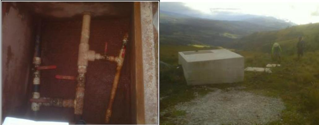
Figura 52. Cámara de bifurcación y Caja de válvulas. Fuente: Acodal, 2009
