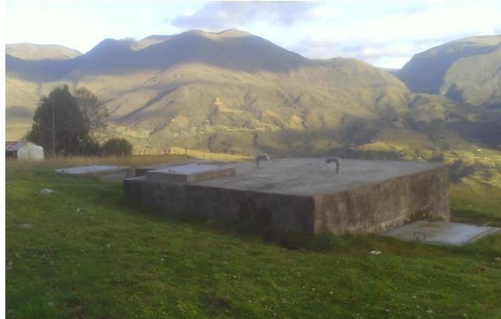
Figura 44. Tanque de almacenamiento. Fuente: Acodal, 2009
