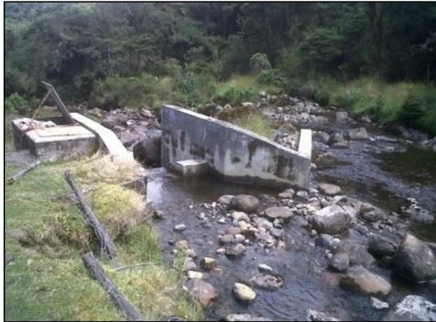
Figura 48. Bocatoma existente.
