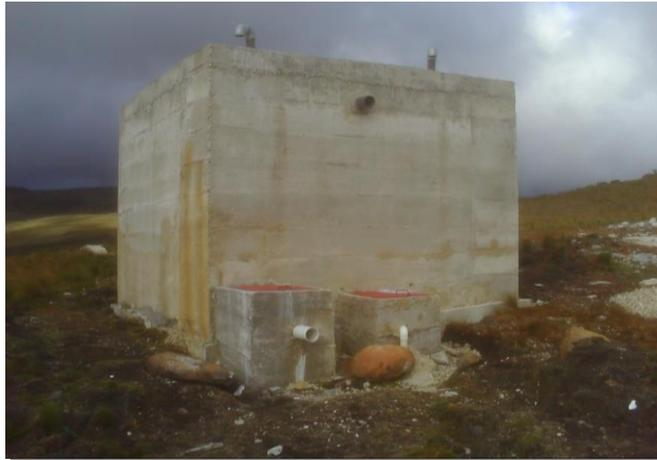
Figura 62. Tanque de Almacenamiento y/o Distribución Vereda el Toldo.
