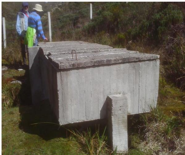
Figura 49. Desarenador tipo convencional en concreto reforzado Aguas Claras.
