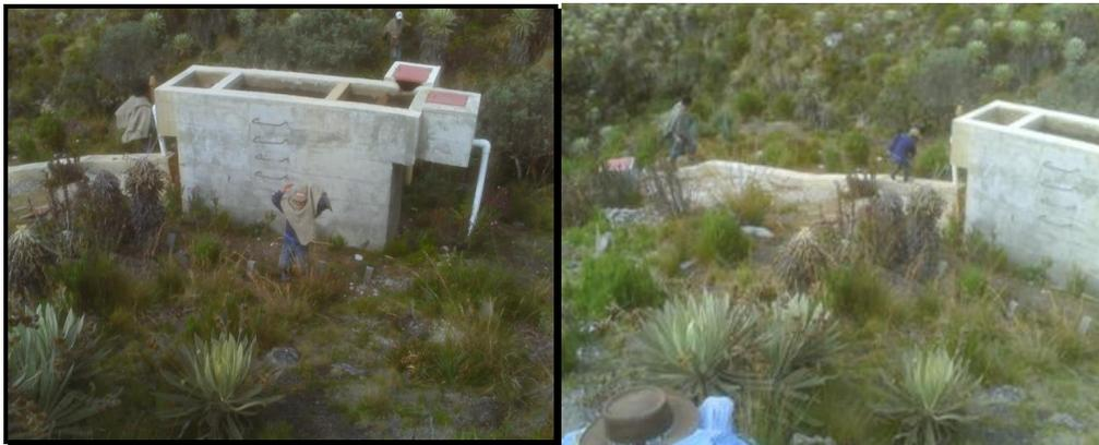
Figura 60. Desarenador tipo convencional en concreto reforzado. Fuente: Acodal.
