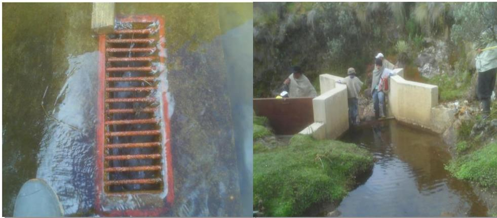
Figura 59. Bocatoma de fondo y Rejilla-Bocatoma de fondo sobre Quebrada Honda.
