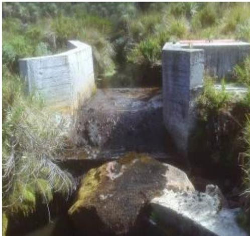
Figura 73. Bocatoma de fondo Quebrada Hoya del Espejo.
