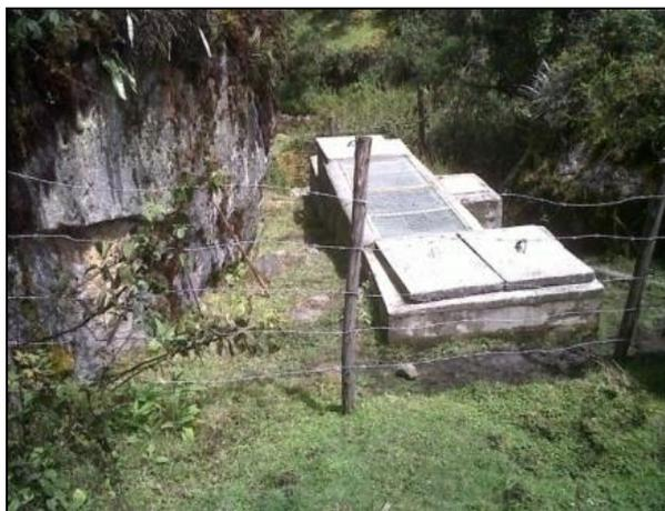
Figura 51. Desarenador existente. Fuente: visita SDHT 2012
