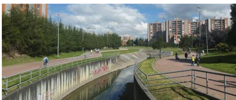
Fotografía 41. Canal Torca, con el corredor ambiental.
