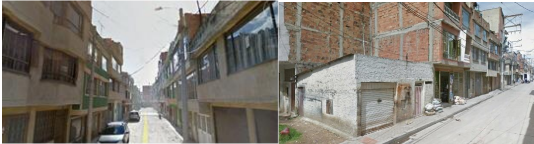
Fotografía 21. Vista calle, sector norte
