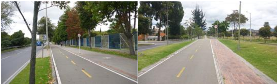
Fotografía 16. Ciclo ruta andén frente al predio del Colegio de La Salle por la calle 170.
