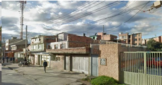
Fotografía 28. Vista calle, sector norte.
