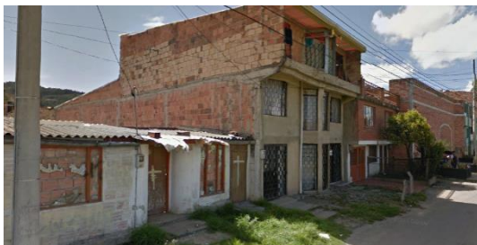
Fotografía 27. Vista calle, sector norte.
