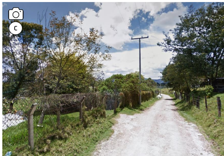
Imagen 07. Estado actual de la vía carreteable Calle 207, sobre la cual se construirá la Avenida Parque Guaymaral Sur.
