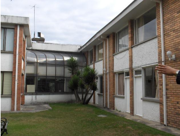
Fotografía 26: Edificio Hospitalización Fuente: Elaboración propia
