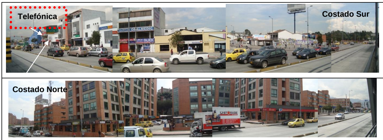
Fotografía 5: Avenida Suba entre Avenidas Constitución y Pepe Sierra o calle 116
