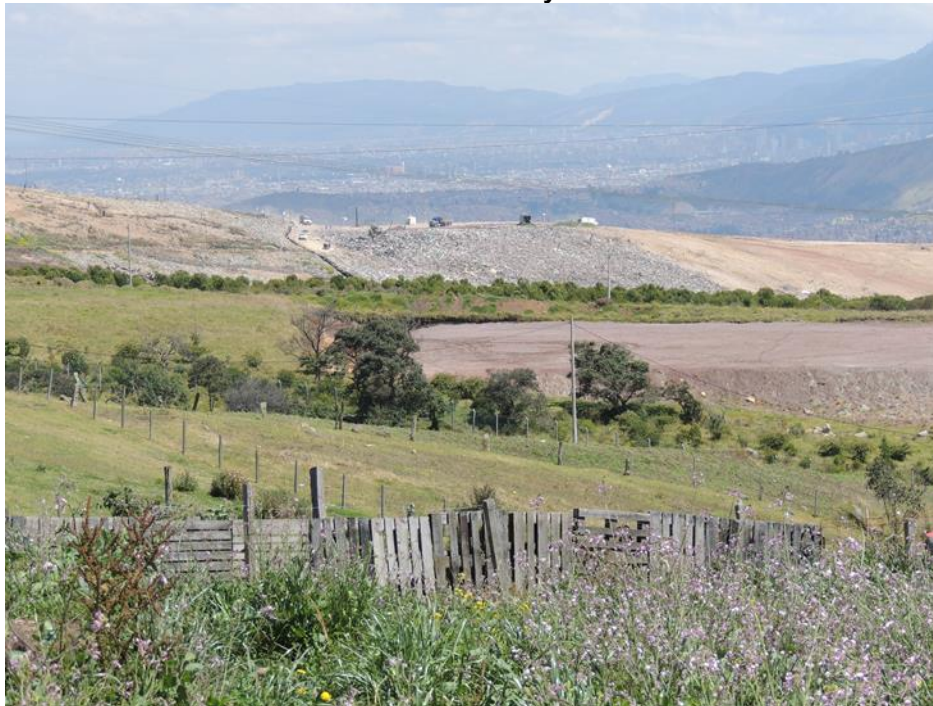
Foto 2. Relleno Sanitario Doña Juana y área rural Ciudad Bolívar
