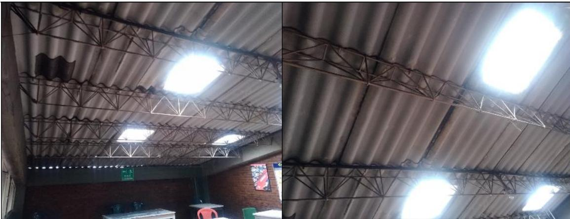
**Fotografías No. 37** - Vista de tejas asbesto cemento al interior del área en estudio.
