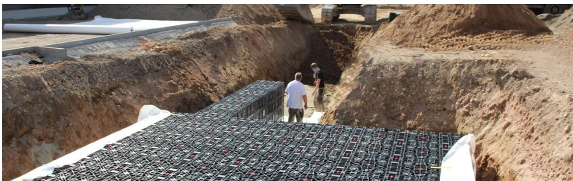
Fotografía 1 Ejemplo de SUDS. Tomado de <https://www.grafiberica.com/suds-drenaje-sostenible/bloques-de-drenaje/ecoblock-light.html>
