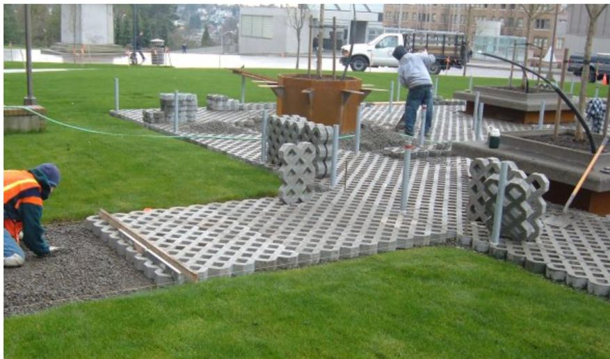
Fotografía 4. Adoquines, como superficies permeables. Fuente: <http://sudsostenible.com/tipologia-de-las-tecnicas/medidas-estructurales/pavimentos-permeables/>
