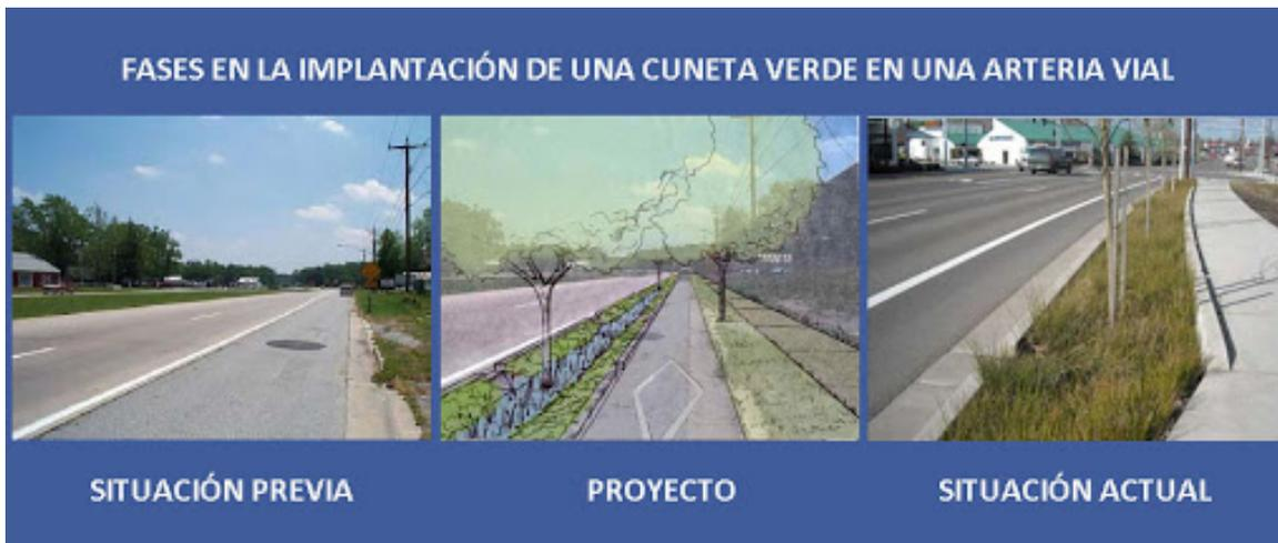
Figura 5 Ejemplo de implementación de una cuneta en vía arteria. Fuente. <http://sudsostenible.com/elementos-de-una-calle-verde-cunetas-vegetadas/>
