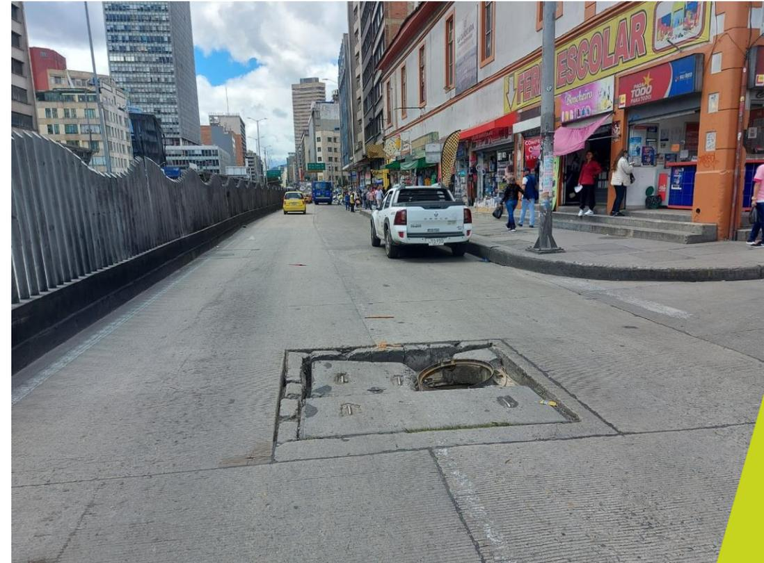
***“Cámara de la EAAB en mal estado (tapa rectangular partida) y que adicionalmente falta la tapa circular (solo está el aro) , representando un peligro latente para los actores del tránsito en el sector.”***
