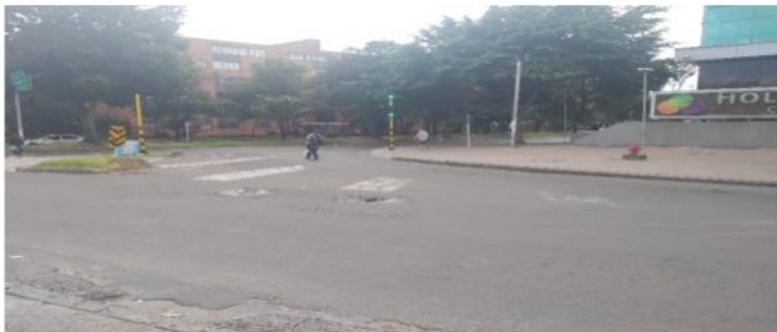
SUMIDERO EN EL EJE DE LA VIA
