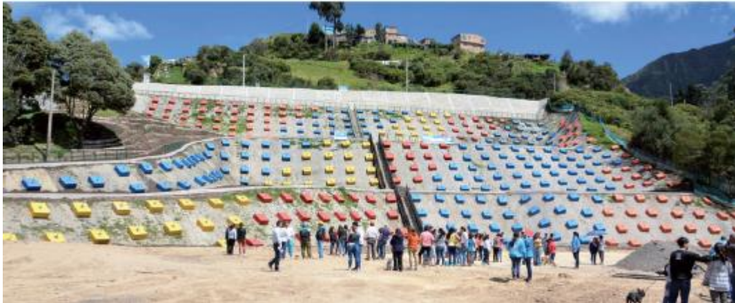
Ilustración 7 Muro de contención barrio La Roca, Alcaldía Local de San Cristóbal, 2018
