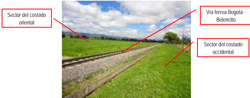
Vía férrea Bogotá – Belencito.
