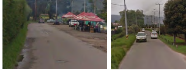
Ilustración 84. Calle 209 (Av. Los Arrayanes) entre Carrera 57 y Carrera 77
