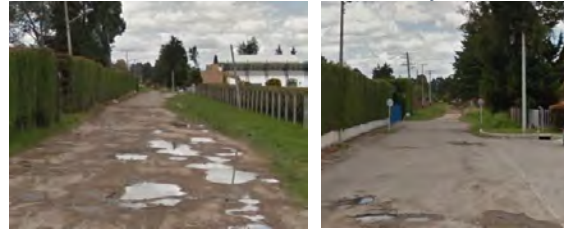
Ilustración 85. Carrera 49 entre Calle 201 y Calle 207
