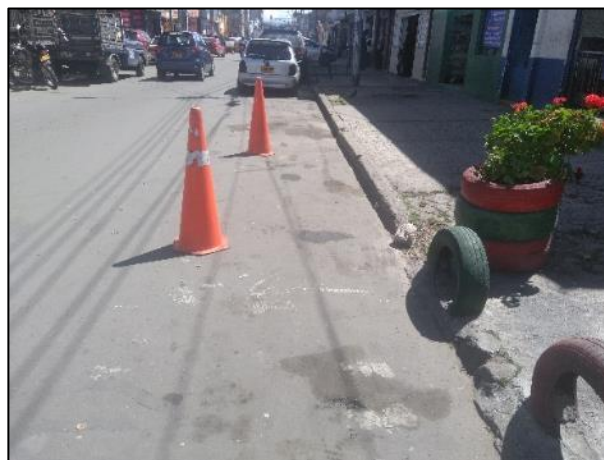
Fotografía 11. Derrames de Hidrocarburos.
