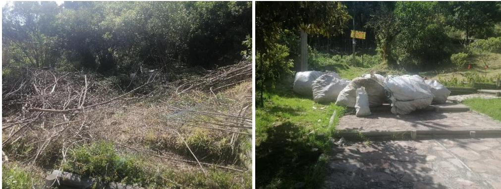
Figura 31. Registro fotográfico visita de verificación - Trabajos en ejecución Corinto
