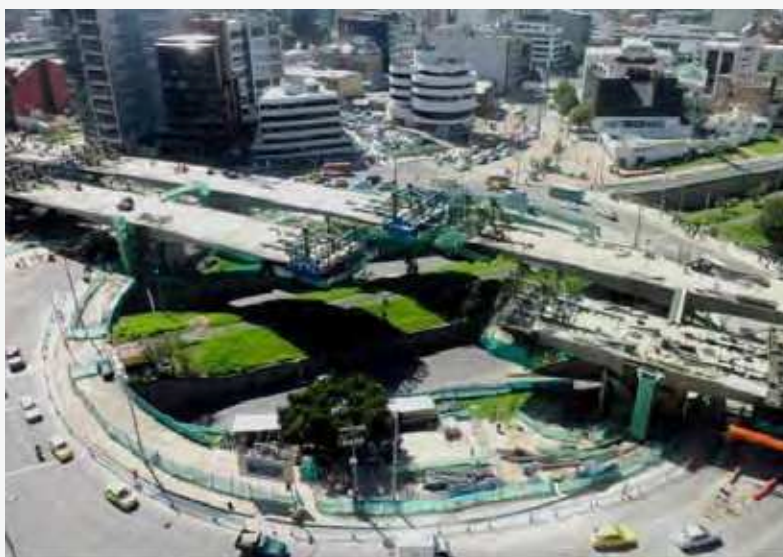
Ilustración 5 Puente vehicular carrera 15 por calle 100
