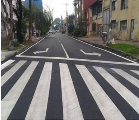
Foto: Vía terminada con señalización
