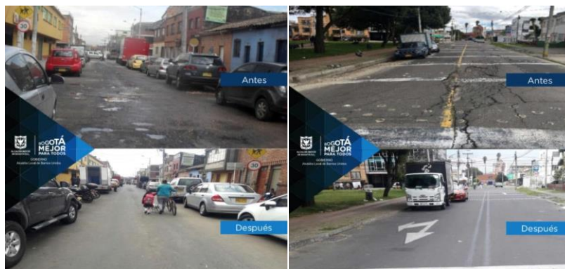
Imagen 15 y 16. Intervenciones a vías de la localidad
