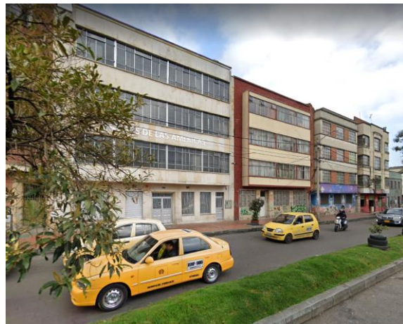
Edificios sobre la Calle 24, entre carreras 17 y 18
