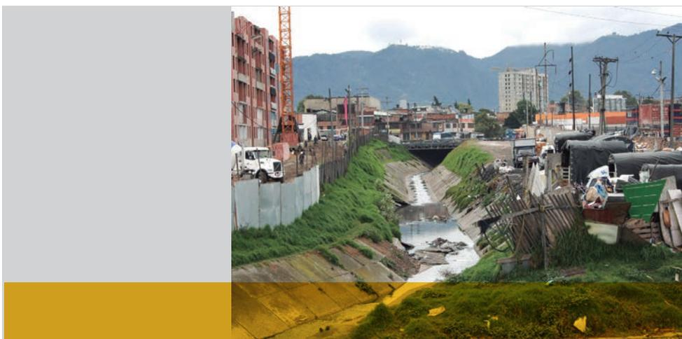
Fotografía 20. Desprendimiento de losas del canal del río Fucha - canal Comuneros
