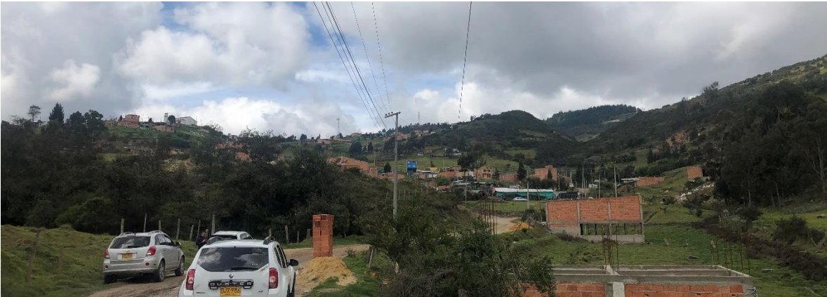
Figura 41 Panorámica Equipamientos Quiba Bajo 2
