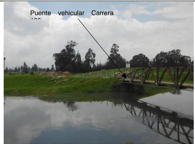
*Fotografía 13 y Fotografía 14. Punto 7. Se verificó la existencia de puntos bajos sobre la margen derecha del río, posiblemente por el emplazamiento de un puente vehicular (Carrera 123); sin embargo se observó continuidad del jarillón y altura aproximadamente constante.*
