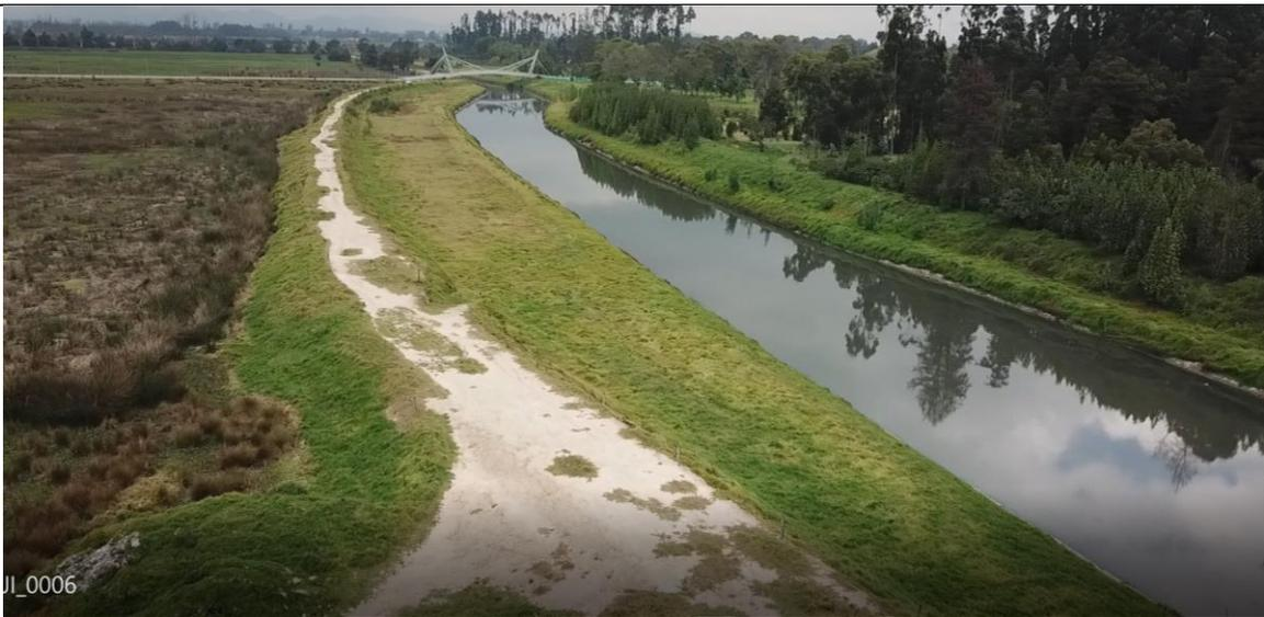
Fotografía 25. Se observa en la fotografía que se modificó el terreno diferente a como se encontraba en el diseño.
