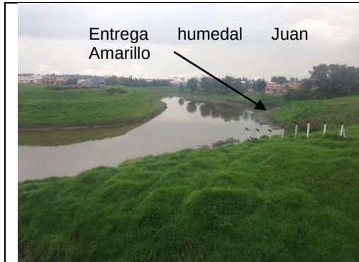
Fotografía 1. Punto 1: Se observa la entrega del humedal Juan Amarillo al río Bogotá y la continuidad de los jarillones.
