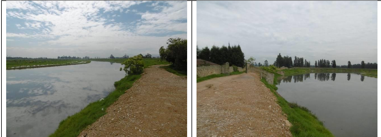
Fotografía 21 y Fotografía 22. Punto 13: Se verificó la continuidad del jarillón, sobre la margen derecha del río Bogotá.
