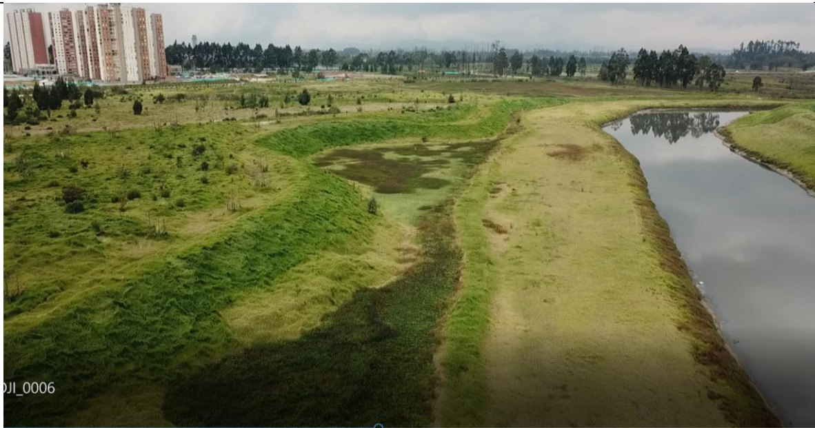
Fotografía 27. Se observa en la fotografía que se realizó un relleno que no estaba en los diseños el cual se incorporó en los ajustes de la amenaza
