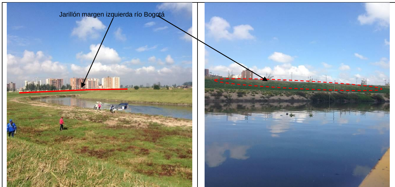
Fotografía 5.y Fotografía 6. Punto 3: Ubicado aproximadamente 540 m aguas debajo de la Calle 80. Se observó continuidad de los jarillones que conforman la margen izquierda del río Bogotá.
