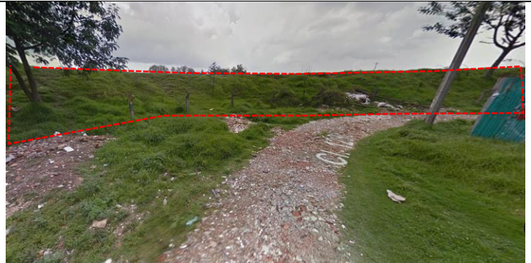
Fotografía 2. Punto 1: Vista del exterior de jarillón del río Bogotá en el sector de Gavilanes de la localidad de Suba.
