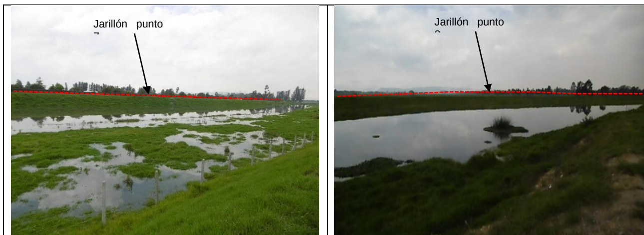
Fotografía 15. Punto 8. Se verificó la continuidad del jarillón, sobre la margen derecha del río Bogotá.
