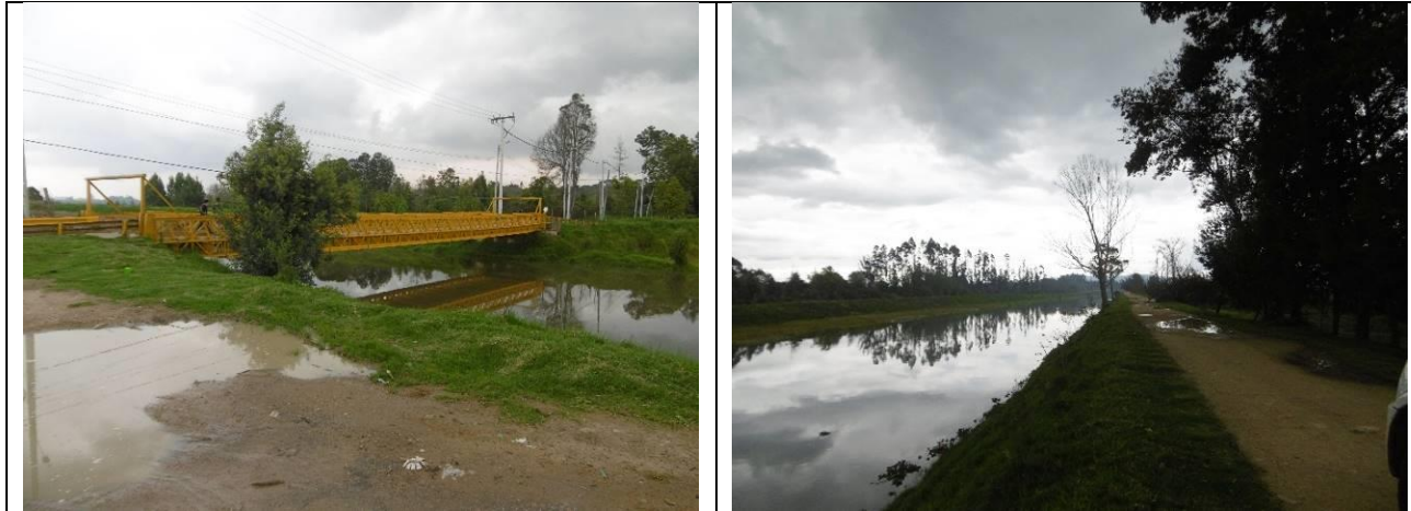
Fotografía 9. Fotografía 10. Punto 5. Se observa el margen izquierdo del río Bogotá que colinda con el costado noroccidental del humedal Jaboque, donde el jarillón presenta igualmente continuidad.
