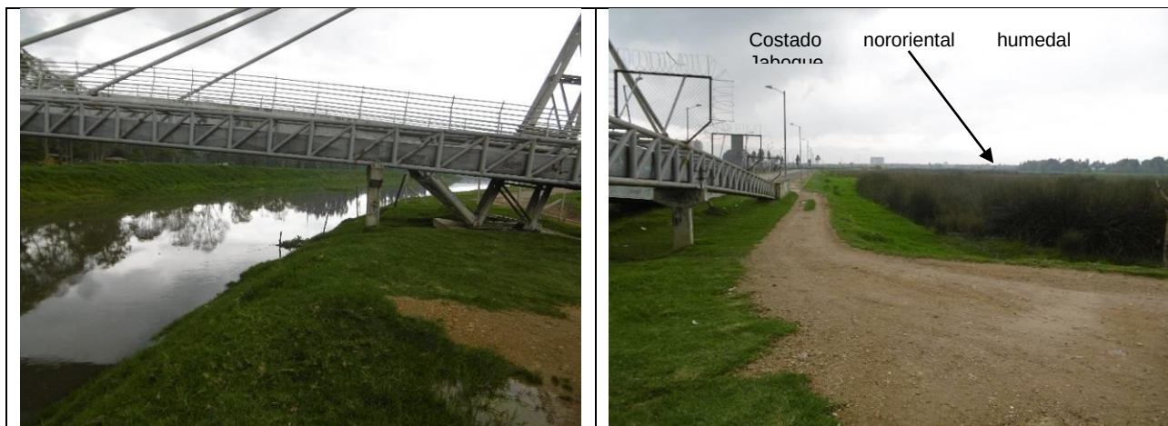
Fotografía 7. Punto 4. Se observa el margen izquierdo del río Bogotá que colinda con el costado nororiental del humedal Jaboque, donde el jarillón presenta continuidad.
