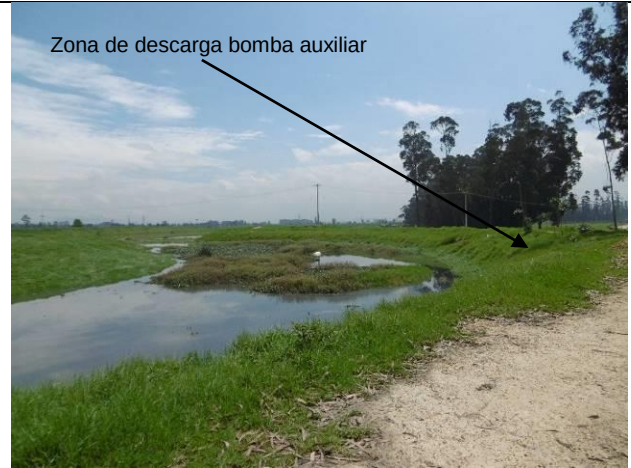
Fotografía 18. Punto 11. Se verificó la continuidad del jarillón, sobre la margen derecha del río Bogotá, donde hace descarga bomba auxiliar de la EAB – ESP que extrae agua del canal Cundinamarca.
