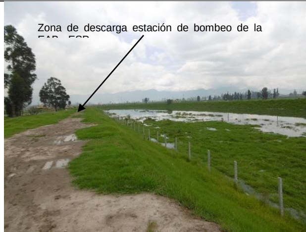
Fotografía 17. Punto 10. Se verificó la continuidad del jarillón, sobre la margen izquierda del río Bogotá, donde hace descarga la estación de bombeo de la EAB – ESP.
