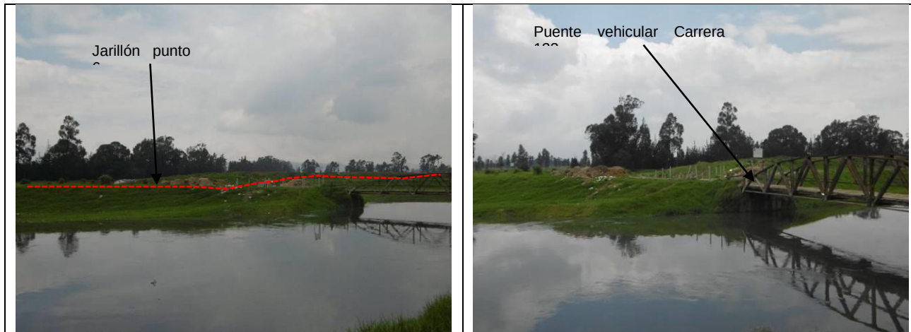
Fotografía 13 y Fotografía 14. Punto 7. Se verificó la existencia de puntos bajos sobre la margen derecha del río, posiblemente por el emplazamiento de un puente vehicular (Carrera 123); sin embargo se observó continuidad del jarillón y altura aproximadamente constante.
