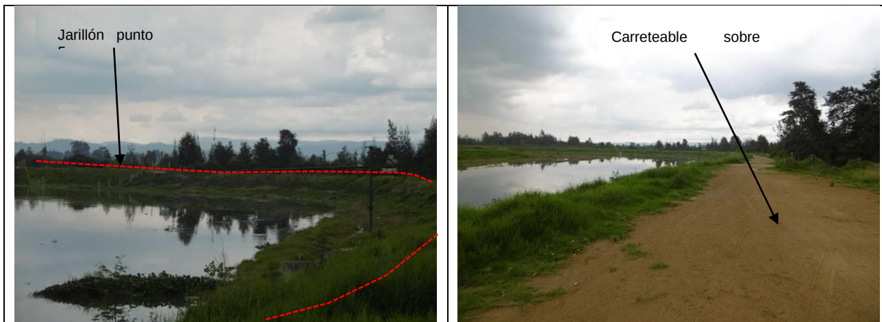
Fotografía 11 y Fotografía 12. Punto 6. Se verificó la continuidad del jarillón sobre la margen izquierda donde el río presenta un comportamiento sinuoso.
